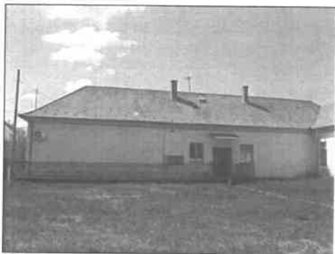
Irodai rész udvari homlokzata
